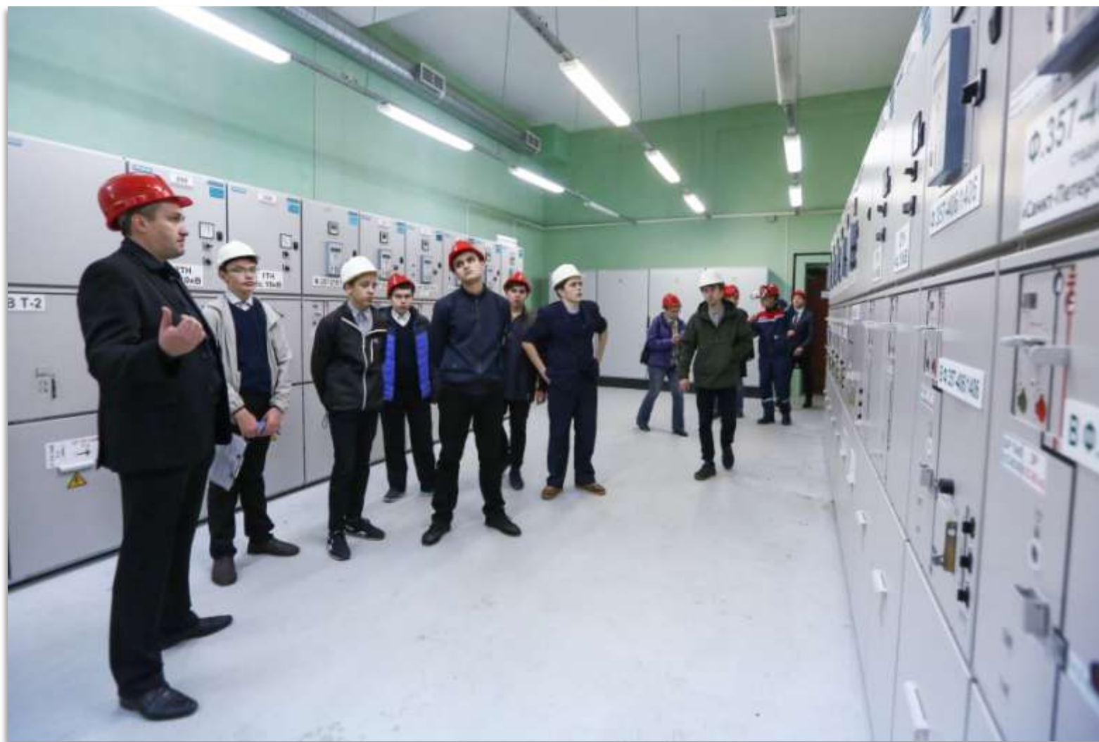
Ленэнерго Подстанция Крестовская
